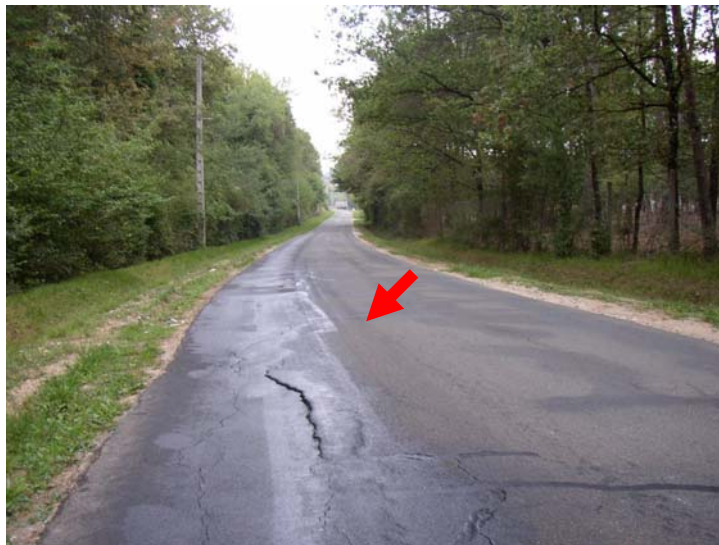
Figure 5 et 6. exemple de tassement de part et d'autre d'une fissure de retrait (VC6 à Choussy - 41 - )
