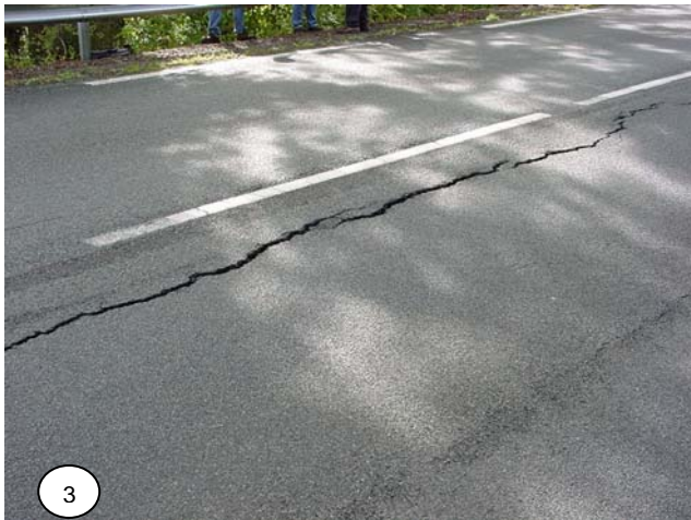
Figure 3. exemple de fissure de retrait sur chaussée en profil mixte (St Satur (18)– RD 955)
