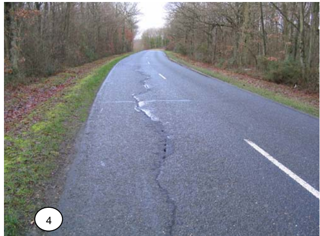
Figure 3. exemple de fissure de retrait sur chaussée en profil mixte (St Satur (18)– RD 955)
