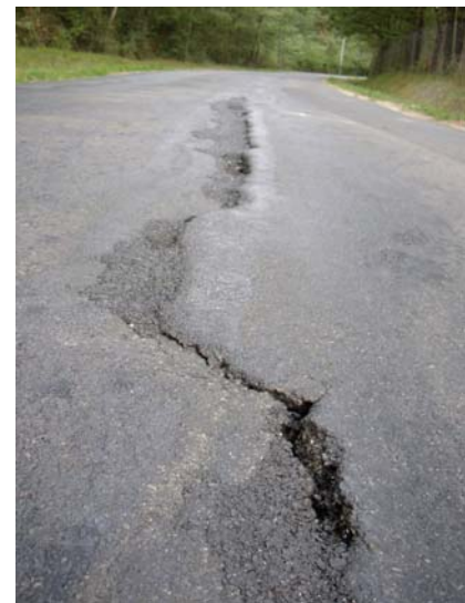
Figure 5 et 6. exemple de tassement de part et d'autre d'une fissure de retrait (VC6 à Choussy - 41 - )
