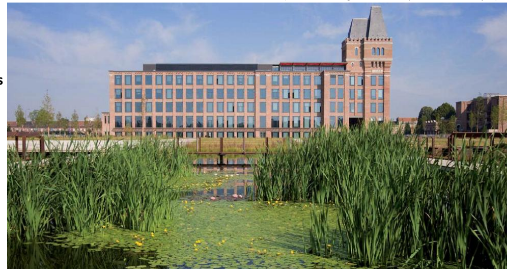
Rives de la Haute Deûle à Lille – Atelier Pranlas-Descours – Atelier de paysages Bruel-Delmar (Source : Ecoquartiers suivez le guide)
